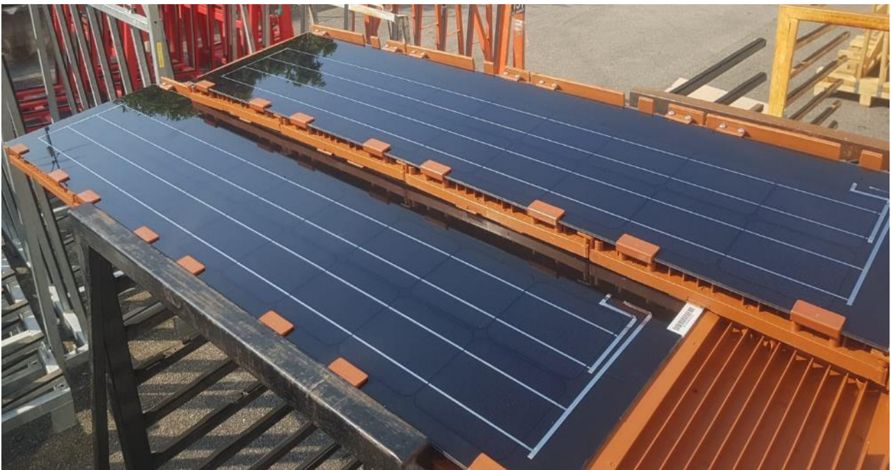
SOTTILE on-site assembly test
